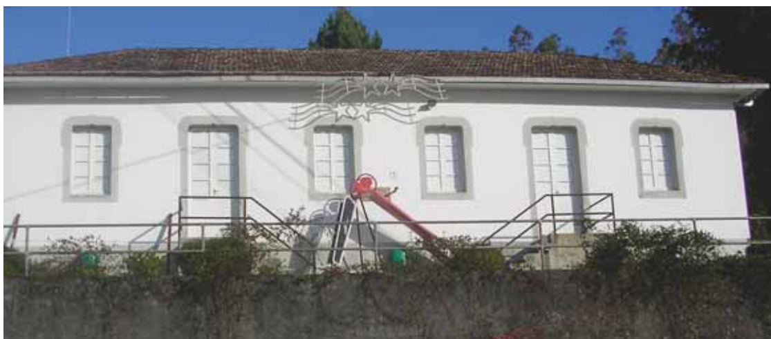
Edificio da escola República Argentina no lugar de Picón, San Pedro de Vilanova
