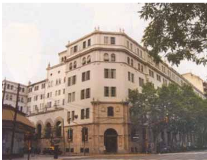
Fachada principal do Centro Gallego de Bos Aires esquina Belgrano e Pasco
