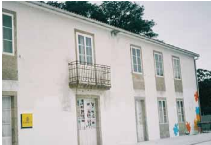
Edificio onde se atopa a Biblioteca
